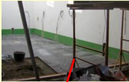
Très vite une semelle de béton est lissée, remplaçant les carreaux les de la cour. Le temps de souffler dessus et hop ! les belles dalles en céramique gris-brun viennent s'aligner. Ce sont les mêmes que celles de la véranda. Elles assureront une belle continuité de l'ensemble. L'installation électrique sort des murs. Ce sera mmmhhh magnifique... C'est clair, on imagine déjà un jardin (voir photo à la page suivante).
